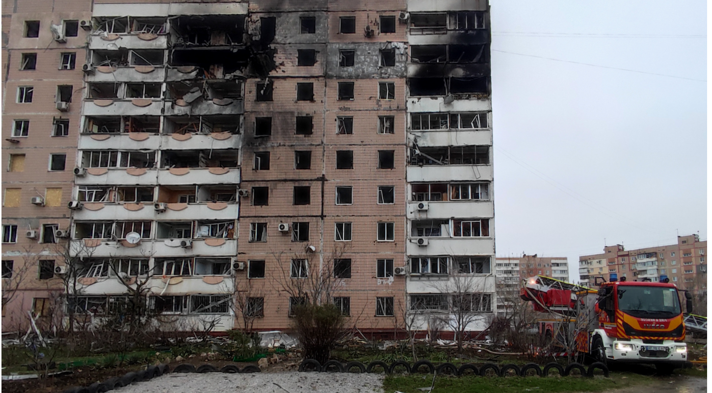
Житловий будинок, пошкоджений під час авіаційного бомбардування Запоріжжя 17 грудня 2025 року.
